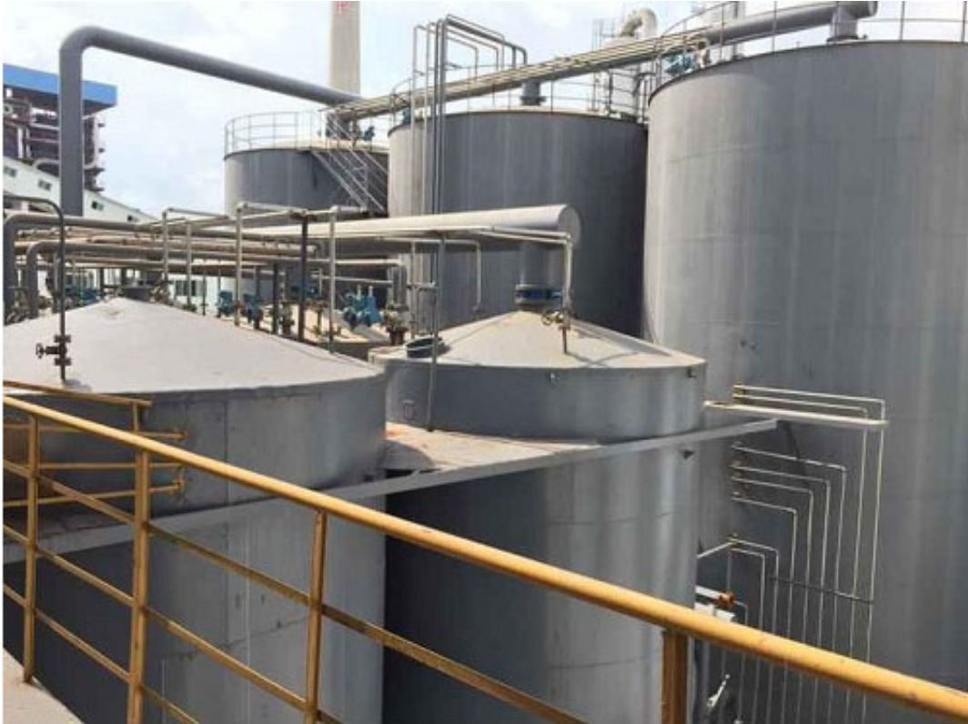
示范工程现场
